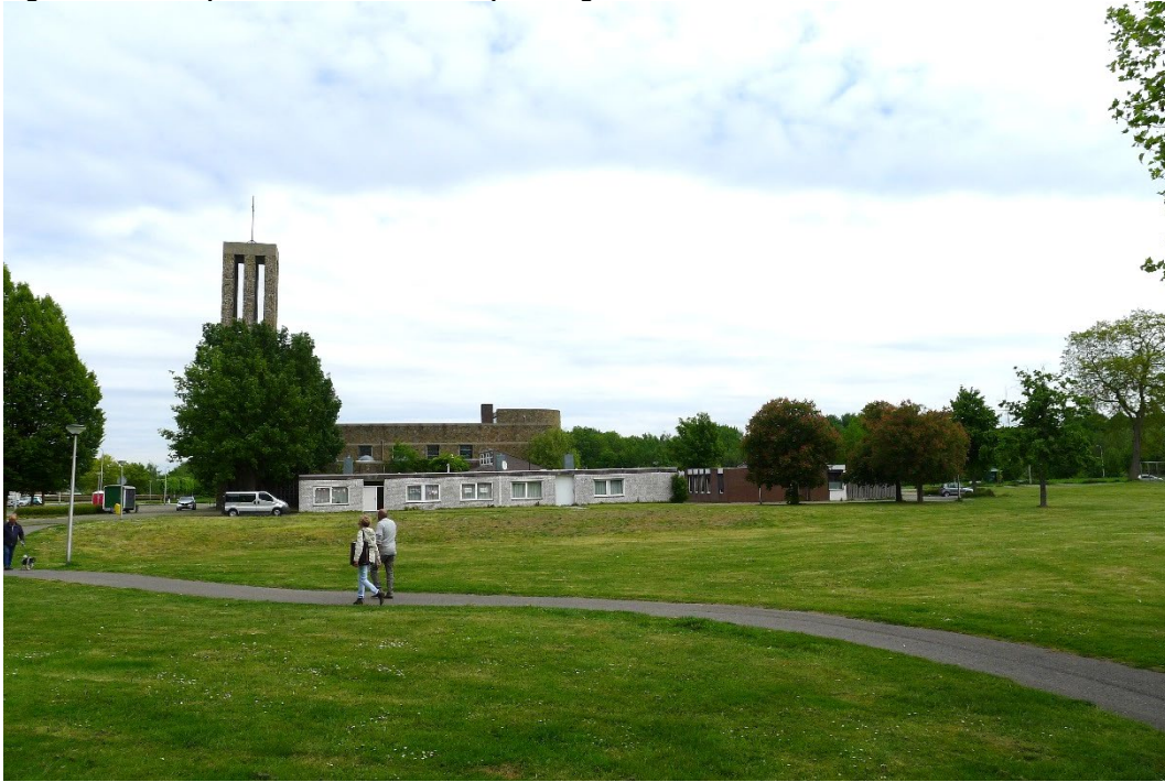
Figuur 3 Nieuwe openbare ruimte door sloop woningen Wonen Zuid te Kerkrade.
